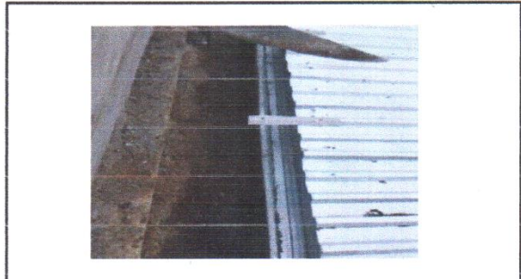
Foto 2: Sustitucion de canal de metal por otro canal de metal atrás de la escuela.
