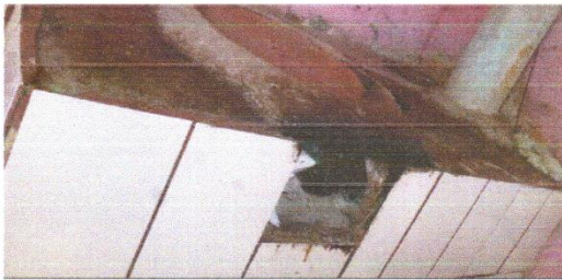
9. SUSTITUCIÓN DE ESTUFA RURAL, INCLUYE CHIMENEA PLANCHA DE METAL
