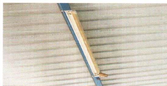
6. SUSTITUCIÓN DE PLAFONERAS DE CADA AULA Y CORREDOR
