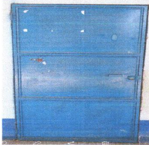
5. SUSTITUCIÓN DE PUERTAS DE LAS CUATRO AULAS
