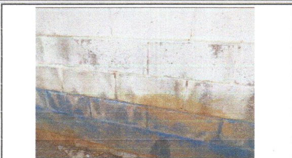
7. PINTURA EN MUROS INTERNOS Y EXTERNOS
