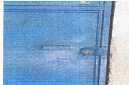
4. SUSTITUCIÓN DE UNA CHAPA DE LA PUERTA DE LA DIRECCIÓN
