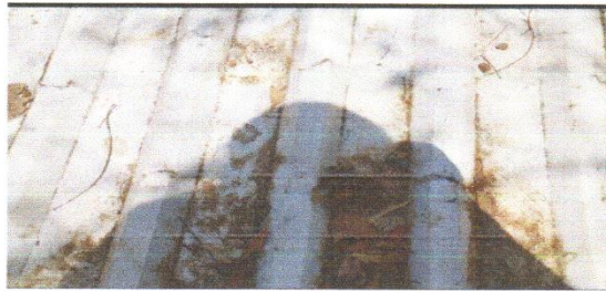
1. SUSTITUCIÓN DE LÁMINA POR LÁMINA TROQUELADA DE LAS AULAS
