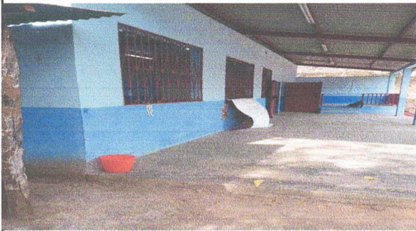
Foto1: PINTURA EN AULAS.
