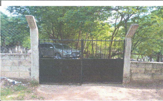
Foto 7: REMOZAMIENTO DE PORTON ENTRADA PRINCIPAL.
