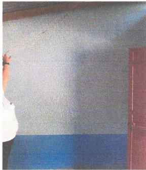
Foto 9: DEMOLER AREA PARA VENTANA
