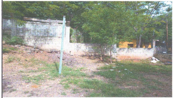
Foto 8: PINTURA EN MUROS.
