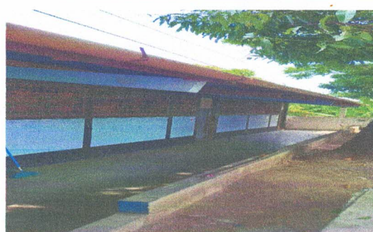
Foto 4: Instalación de canal.
