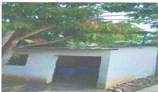
Foto 5: Sustitución de lamina y estructura de soporte en cocina.
