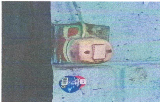
Foto 3: Sustitución de interruptores.
