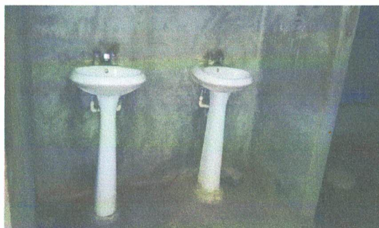
Foto 10: Sustitución de accesorios de lavamanos.
