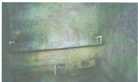
Foto 11: Instalación de agua y azulejos.
