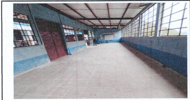
Foto 1: Aula finalizada con la instalación de metros de piso cerámico.
