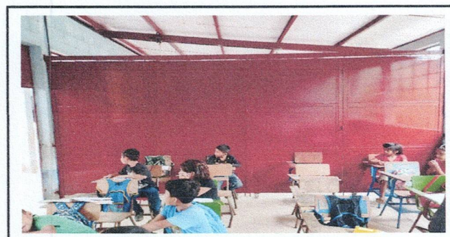
Foto 6: En aula se puede observar la división de metal ya instalada.
