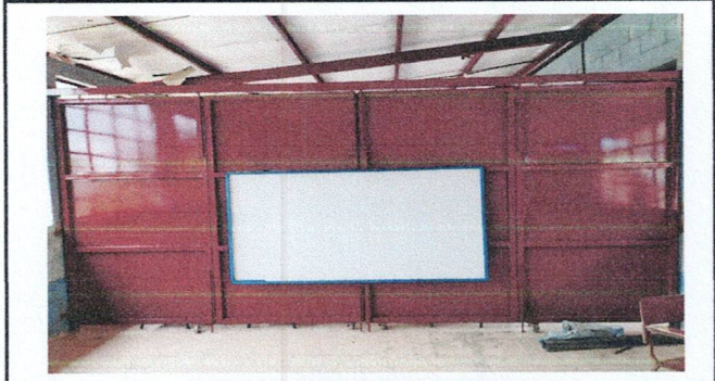
Foto1: Se observa aula con división de metal ya instalada.
