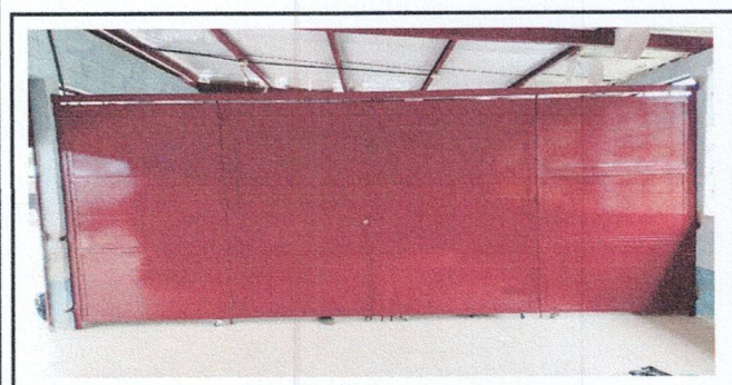
Foto 5: División de metal instalado en aula.
