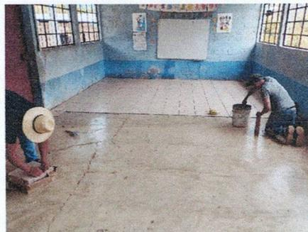
Foto 4: Instalación de piso cerámico en aulas.
