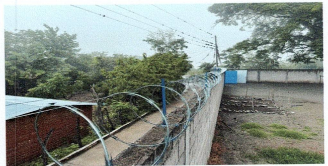
Foto 6 Protección de muro perimetral con Razor Ribbon
