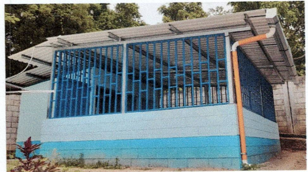
Foto 4 Proyecto de cocina finalizado
