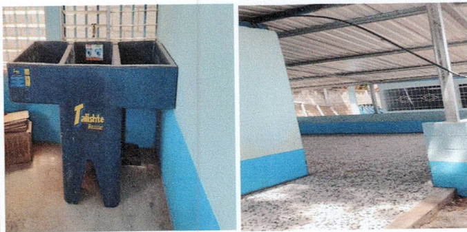
Foto 3 Pila plástica de dos lavaderos, instalación de piso de granito
