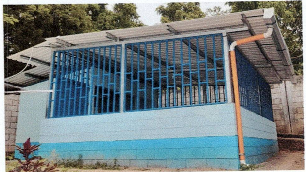
Foto 4 Proyecto de cocina finalizado
