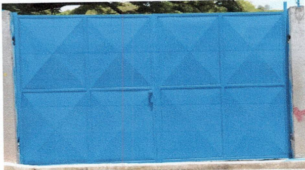
Foto 5 Instalación de Portón de metal
