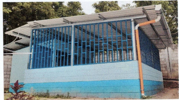
Foto 4 Proyecto de cocina finalizado
