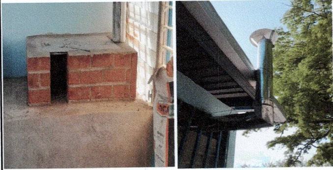
Foto 1 Instalación de estufa rural completa
