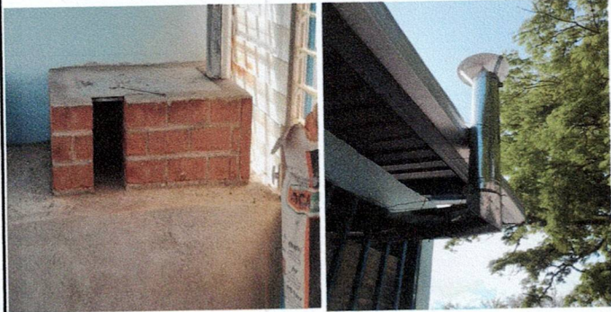
Foto 1 Instalación de estufa rural completa
