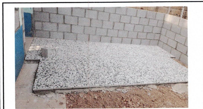
Foto 3. Instalación de piso de granito
