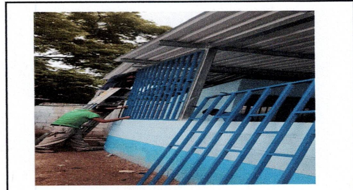
Foto 4. Instalación de balcones de metal
