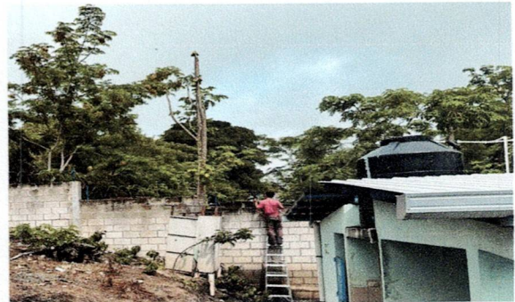
Foto 6. Instalación de Razor Ribbon
