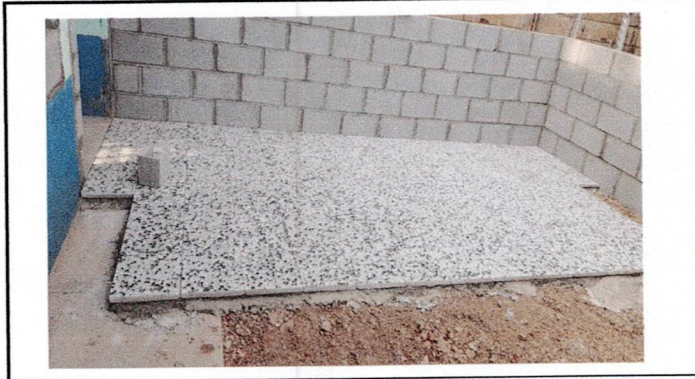
Foto 3. Instalación de piso de granito
