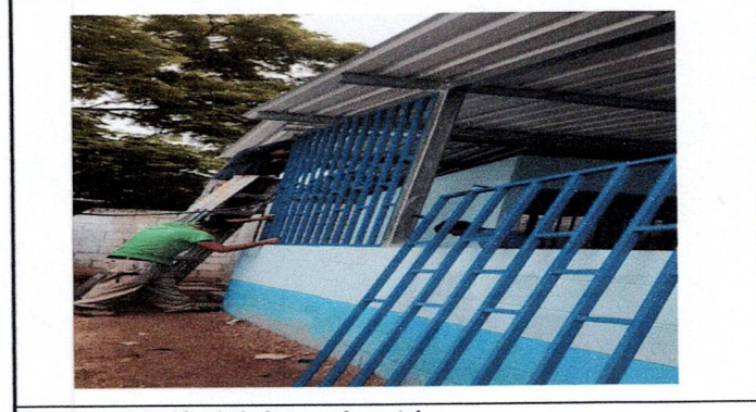
Foto 4. Instalación de balcones de metal
