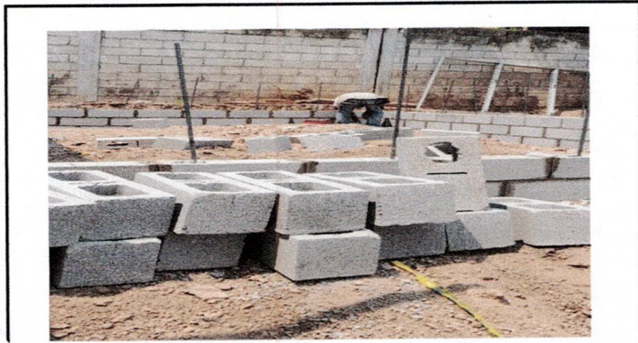
Foto 1. Ampliación de cocina
