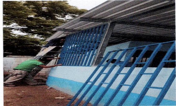
Foto 4. Instalación de balcones de metal
