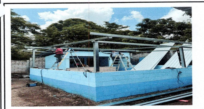
Foto 5. Instalación de estructura de soporte y de lamina
