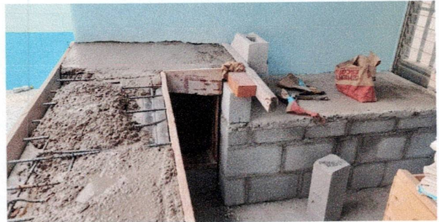
Foto 2. Construcción de mueble de concreto
