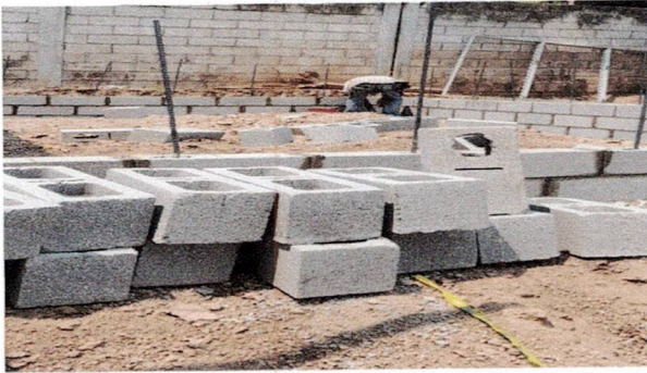
Foto 1. Ampliación de cocina
