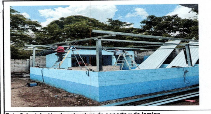
Foto 5. Instalación de estructura de soporte y de lamina
