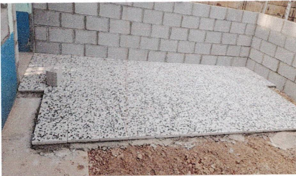
Foto 3. Instalación de piso de granito
