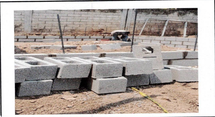
Foto 1. Ampliación de cocina
