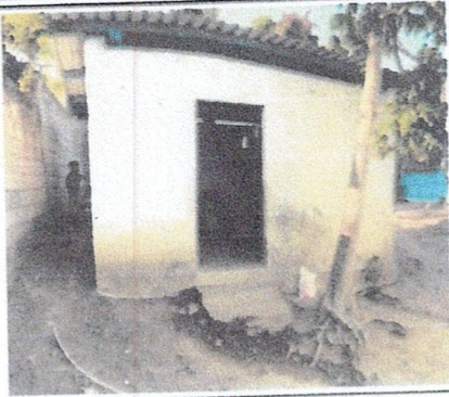
Foto 1: Reparación de Cocina.
