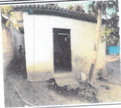
Foto 1: Reparación de Cocina.
