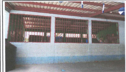
Foto 3: INSTALACIÓN DE MALLA MOSQUITERA EN BALCONES.
