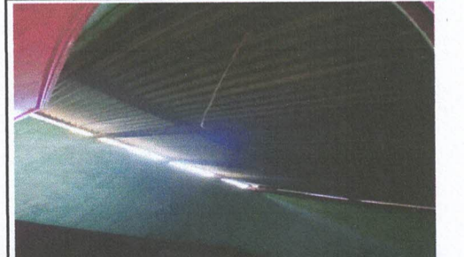
Foto 4: SUSTITUCIÓN DE LAMINA Y ESTRUCTURA DE SOPORTE EN COCINA.
