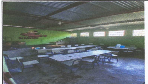
Foto 1: SUSTITUCIÓN DE LAMINA, SISTEMA ELECTRICO EN AULAS.
