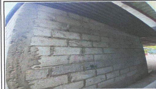
Foto 5: LEVANTADO, REPELLOS, CERNIDOS EN MUROS DE COCINA.
