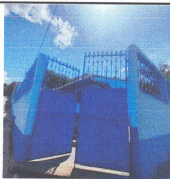
Foto 6: Sustituir Estructura Existente y Luego Sustituir Lámina Troquelada C26 Legítima en PATIO Y ACCESO PRINCIPAL. Y Aplicación Pintura Latex Parte Externa Muro Perimetral.
