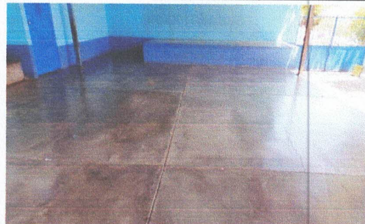
Foto 12: Reparación de Base en mal estado y Sustitución de Piso torta por Piso Cerámico.
