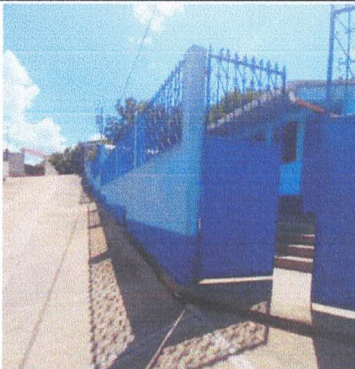
Foto 7: Sustituir Estructura Existente y Luego Sustituir Lámina Troquelada C26 Legítima en PATIO Y ACCESO PRINCIPAL. Y Aplicación Pintura Latex Parte Externa Muro Perimetral.
