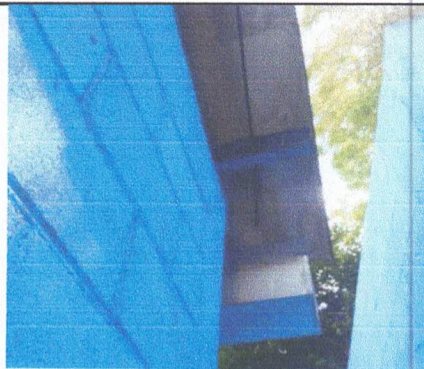
Foto 4: Reparación de Cubierta de Techo de AULA. Debe Removerse la Lámina Perfil 10 o de Asbesto cemento para darle Mantenimiento a la Estructura Existente y Luego Sustituir Lámina Troquelada C26 Legítima. Fijación de Canales Metalicos y BAP.
