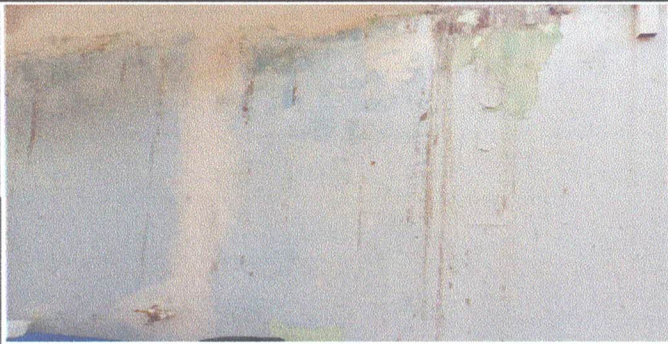
Foto 1: PINTURA EN MUROS EXTERIORES E INTERIORES ✓
