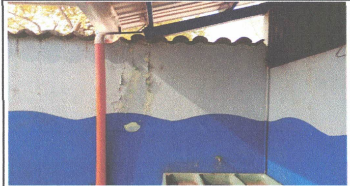
Foto 2: PINTURA EN MUROS EXTERIORES E INTERIORES ✓
