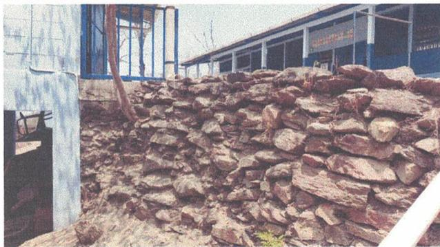
Foto 3: MURO DE CONTENCIÓN: Sustrución de muro de contención
