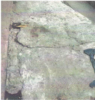
Foto 5: sustitucion de plancha de concreto en patio
