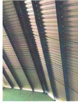
Foto 2: instalacion de cielo falso en techo
