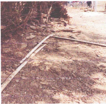
Foto 3: BAÑOS: Sustitución de Red tubería principal de agua Potable.
