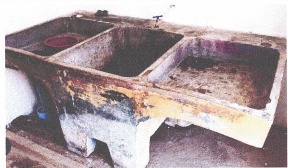
Foto 6: COCINA: sustitución de pila plástica de 2 lavaderos.
