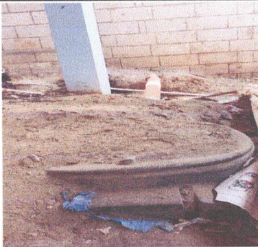
Foto 5: BAÑOS: Reparación de Fosa séptica.
