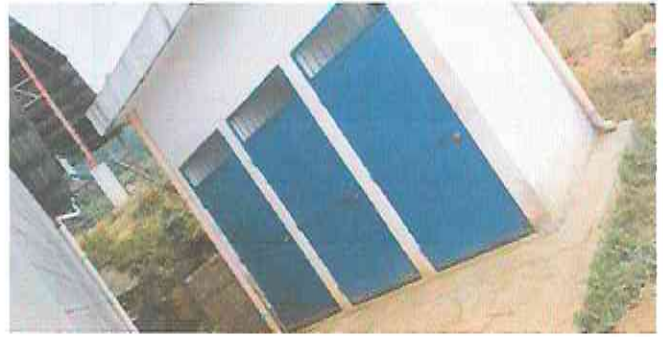
Foto 2: Techo de corredor de baños
