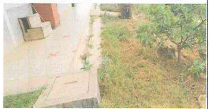
Foto 4: Muro de sostenimiento del corredor
