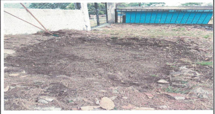
Foto 2: Seguimiento de fosa séptica para servicios sanitarios.
