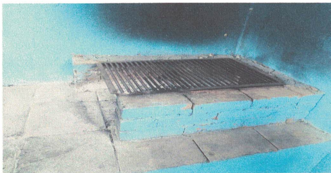
Foto 9: Sustitución de estufa en la cocina.
