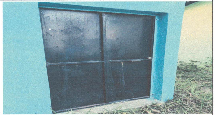
Foto 8: Reapación, mantenimiento y sustitución de chapa en puerta metálica de cocina.
