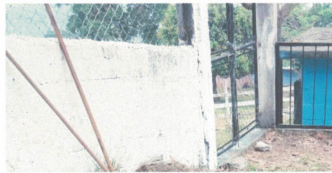
Foto 11: Continuidad de muro perimetral.
