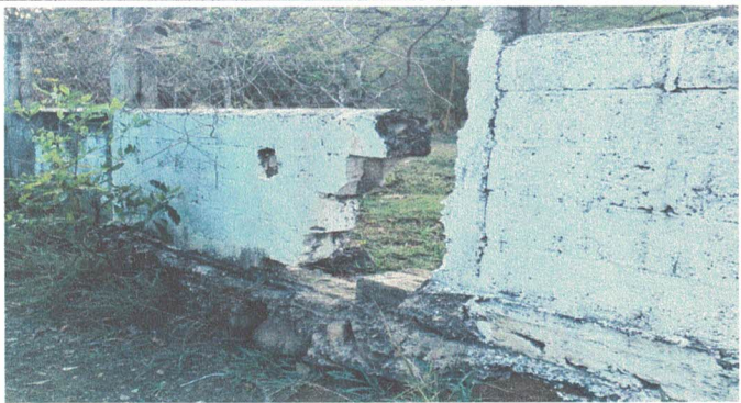
Foto 3: Sellado y reparación de muro perimetral.
