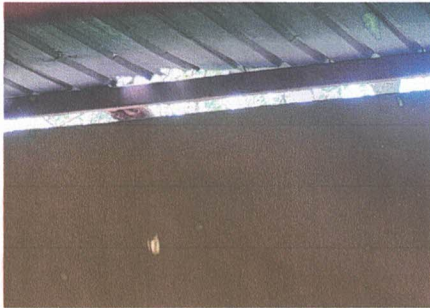
FOTO 3: SUSTITUCIÓN DE LAMINA POR LAMINA TROQUELADA ALUZIN CAL. 28
