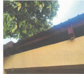
FOTO 2: SUSTITUCIÓN DE LAMINA POR LAMINA TROQUELADA ALUZIN CAL. 28 26
