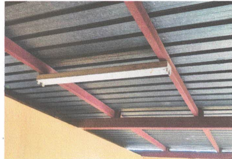
FOTO 4: SUSTITUCIÓN DE SISTEMA ELECTRICO EN TODO EL ESTABLECIMIENTO
