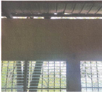
FOTO 1: SUSTITUCIÓN DE LAMINA POR LAMINA TROQUELADA ALUZIN CAL. 28
