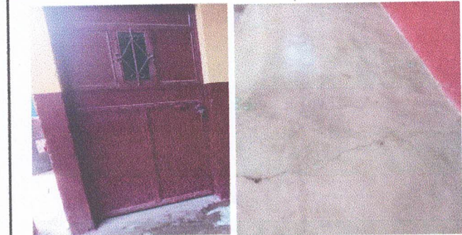
Módulo Aula 4: 4.1 Instalación de piso cerámico, 4.2 Sustitución de puerta
