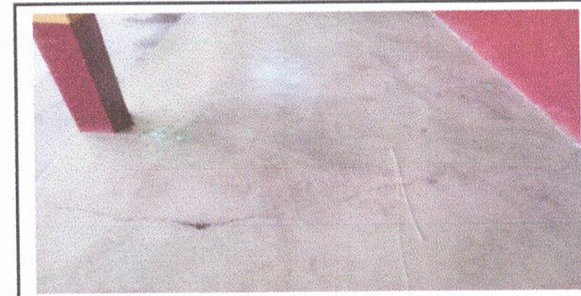
Área de corredor: Instalación de piso cerámico
