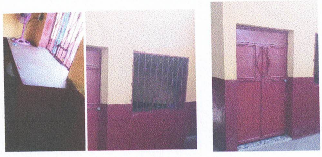
Módulo Cocina: 8.1 Colocación de azulejo en desayunador, 8.2 Sustitución de balcón por ventana de metal, 8.3 Sustitución de puerta
