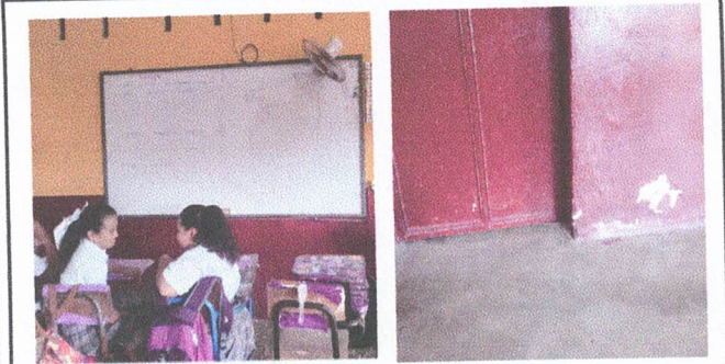
Módulo Aula 1: 1.1 instalación de piso cerámico, 1.2 Sustitución de ventiladores, 1.3 sustitución de puerta
