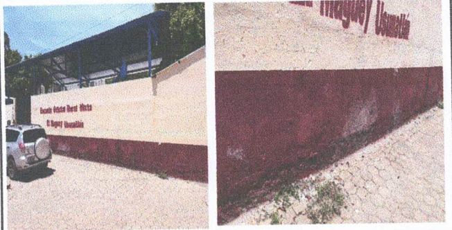
Muro Perimetral: 7.1 Reparación de repello más cernido. 7.2 Pintura (raspado y pintura)
