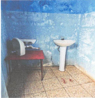
FOTO 5: CAMBIO DE ACCESORIO DE BAÑO
