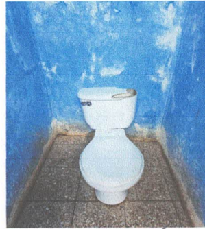
FOTO 4: SUSTITUCIÓN DE BAÑO
