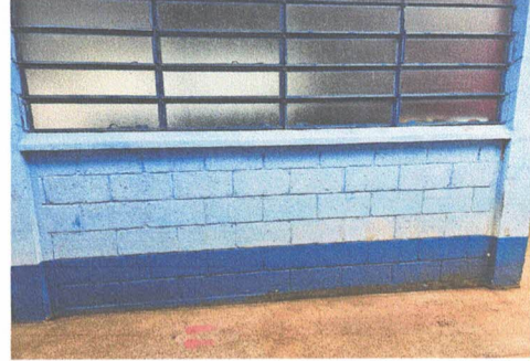
FOTO: SUSTITUCIÓN DE BALCONES
