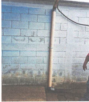
FOTO 7: INSTACIÓN DE DRENAJE FLUVIAL
