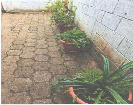
FOTO 3: SUSTITUCIÓN DE PISO DE ADOQUIN POR PISO DE TORTA LISO
