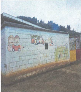
FOTO 9: PINTURA EN MUROS EXTERIORES E INTERIORES
