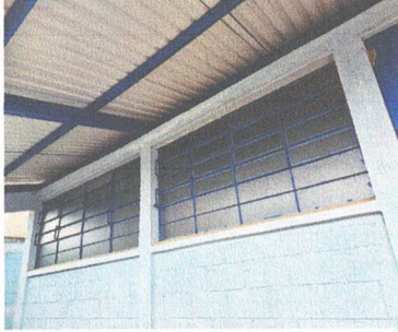
FOTO: INSTACIÓN DE LAMINA TROQUELADA Y ESTRCTURA METALICA
