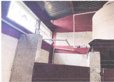
sustitución de llave de cheque y tubería
