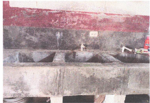
sustitución de llaves de chorros
