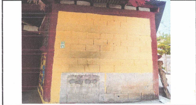
pintura a muros exteriores e interiores
