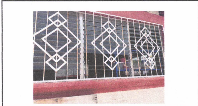
mantenimiento a barandas de metal, lijado y pintura.
