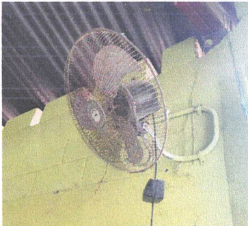
sustitución de ventiladores de pared a ventiladores de techo
