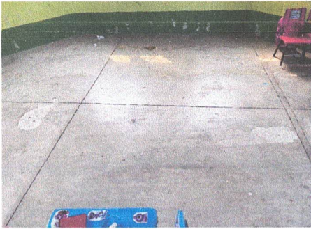
sustitución de piso de concreto a piso granito
