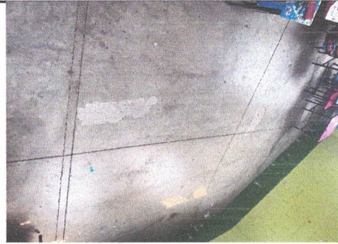
sustitución de piso de concreto a piso granito
