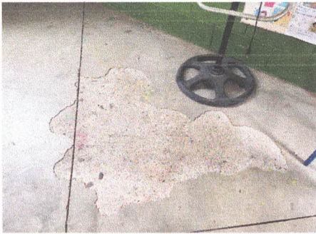
sustitucion de piso de concreto por piso granito
