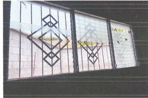
Sustitución de vidrios en ventanas
