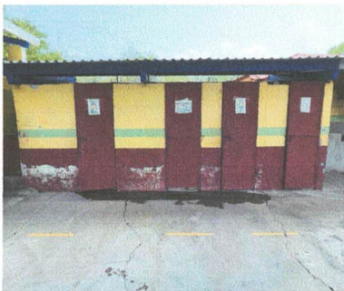
FOTO 11: REPOSICION DE PUERTAS METALICAS 0.70X1.90M
