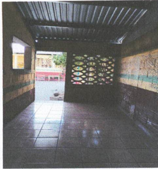
FOTO 19: PINTURA GENERAL EN AULA EXTERNO E INTERNO
