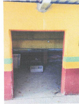
FOTO 8: INSTACIÓN DE PUERTA DE COCINA 0.91 ANCHO X 1.95 LARGO
