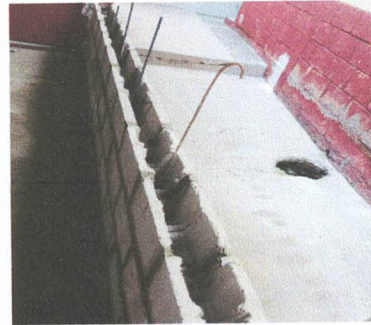
FOTO 4: LEVANTADO DE HILADAS DE BLOCK EN MURO DE COCINA
