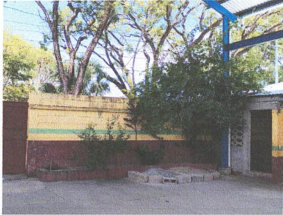
FOTO 21: PINTURA GENERAL MURO PERIMETAL EXTERNO E INTERNO
