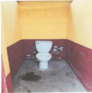
FOTO 15: INSTALACION DE AZULEJO EN BAÑOS
