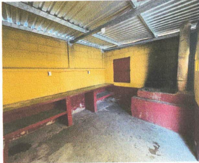
FOTO 1: DEMOLICIÓN Y RETIRO DE MATERIAL DE ESTUFA DETERIORADA EXISTENTE
