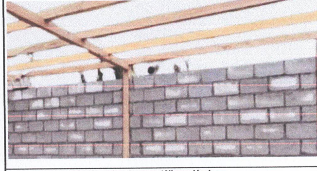
Foto 4: Instalación de estructura metálica y lámina.
