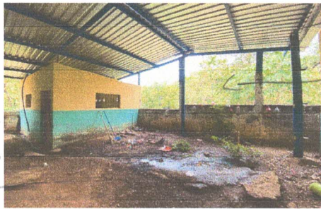
FOTO 3: CONSTRUCCIÓN EN PARED DE COCINA
