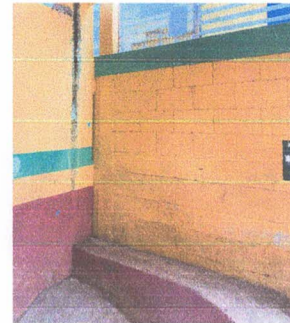
FOTO 4: MANTENIMIENTO DE ESTRUCTURA (LIMPIEZA, LIJADO Y PINTURA)
