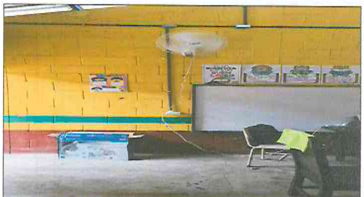
Foto 4: Sustitución de ventiladores.
