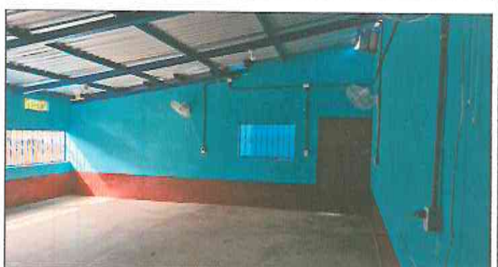
Foto 6: Reparación eléctrica (iluminación y fuerza,
