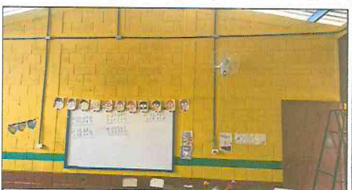
Foto 6: Sustitución de ventiladores.
