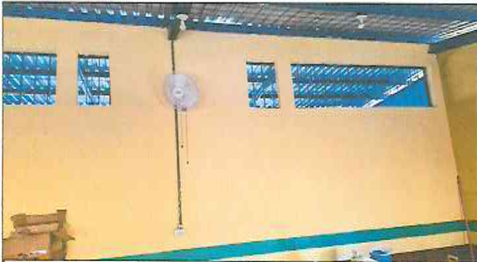
Foto 1: Sustitución de ventiladores.
