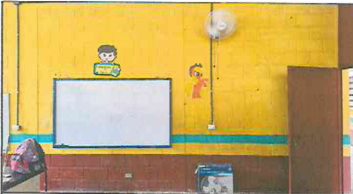
Foto 3: Sustitución de ventiladores.
