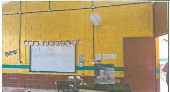
Foto 2: Sustitución de ventiladores.
