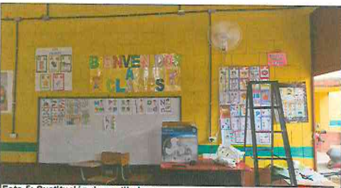
Foto 5: Sustitución de ventiladores.
