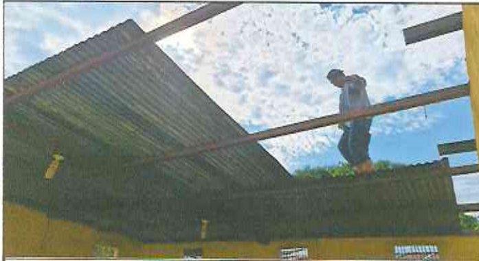
Foto 1: Instalación de lámina troquelada aluzinc cal. 26.
