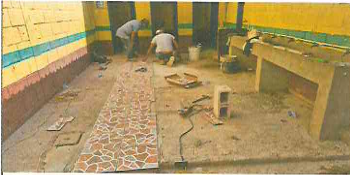
Foto 3: Instalación de piso cerámico (antideslizante) y pintura interior, exterior y puertas.
