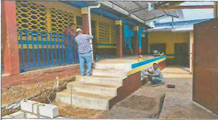
Foto 1: Instalación de baranda metálica en corredor, pintura en escenario.
