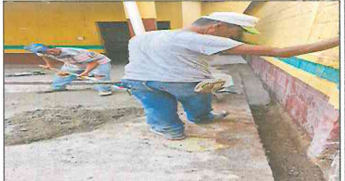
Foto 2: Sustitución de portón de ingreso de 2.5m x 4.00m y techado en área de portón con costanera + lamina troquelada aluzinc cal. 26.
