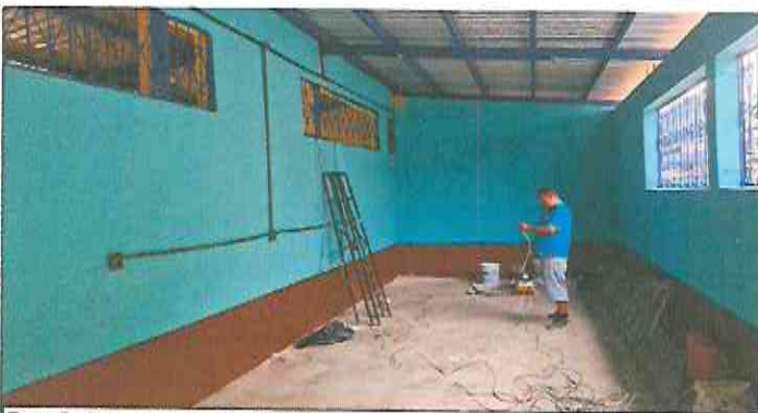
Foto 5: Reparación eléctrica iluminación y fuerza.
