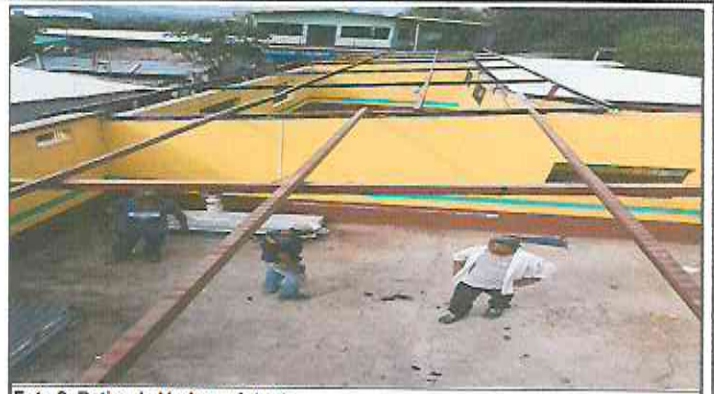
Foto 2: Retiro de lámina existente.
