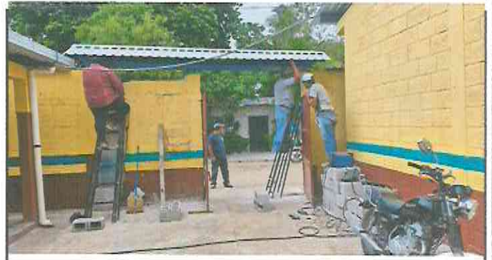
Foto 6: Sustitución de portón de ingreso de 2.5m x 4.00m y techado en área de portón con costanera + lamina troquelada aluzinc cal. 26.
