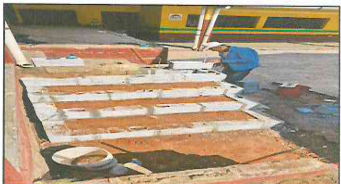
Foto 4: Construcción gradas en escenario.
