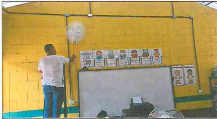
Foto 1: Sustitución de ventiladores.
