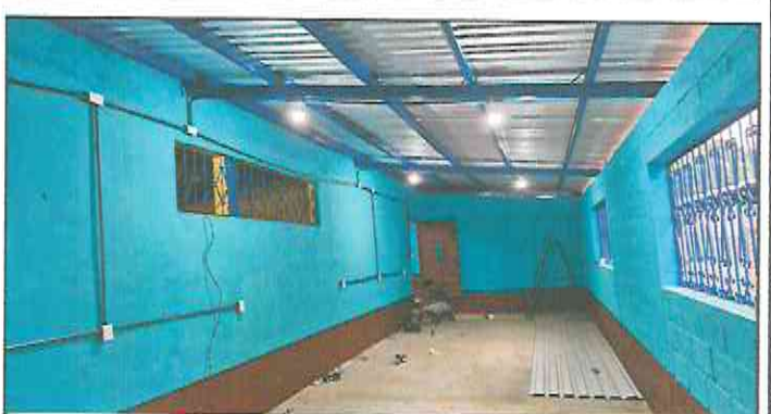
Foto 6: Reparación eléctrica iluminación y fuerza.
