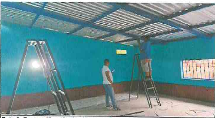
Foto 5: Reparación eléctrica iluminación y fuerza.
