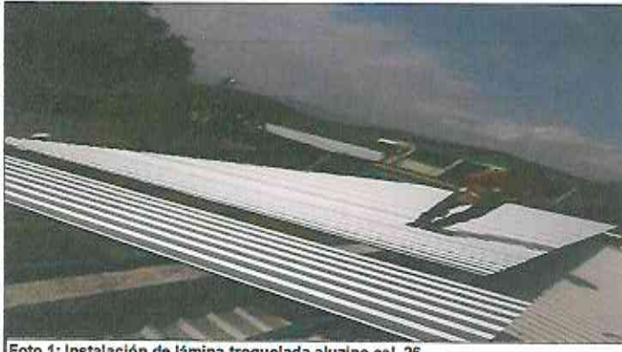
Foto 1: Instalación de lámina troquelada aluzinc cal. 26.
