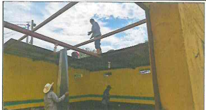
Foto 2: Abertura de ventanas en muro existente de 2.00x1.00mts.
