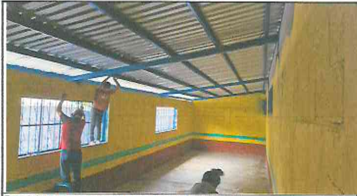
Foto 1: Instalación de lámina troquelada aluzinc cal. 26.
