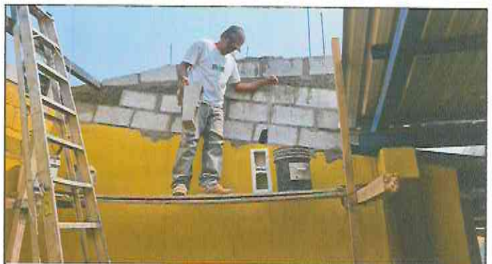
Foto 4: Levantado de hiladas de block.
