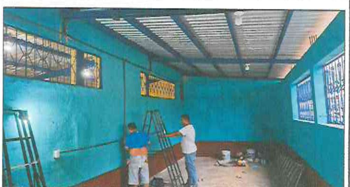
Foto 6: Reparación eléctrica iluminación y fuerza.
