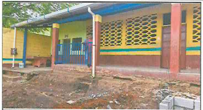
Foto 2: Instalación de baranda metálica en corredor.
