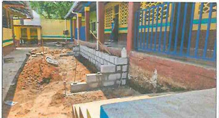
Foto 4: Construcción de gradas de acceso al corredor y banqueta.
