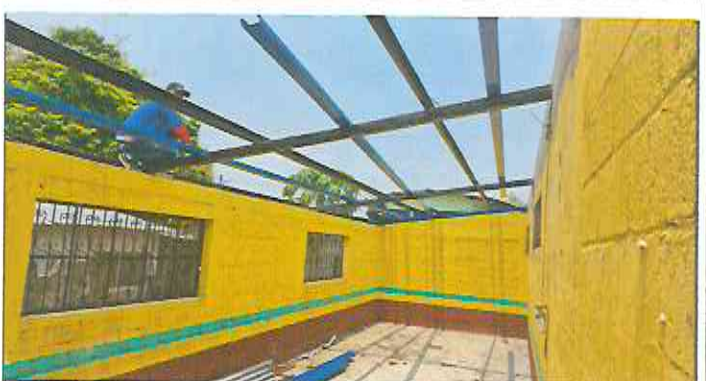
Foto 6: Mantenimiento de estructura existente (limpieza, lijado y pintura anticorrosiva), reforzamiento de estructura con costanera de 2x4.
