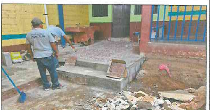
Foto 6: Reparación de torta de cemento e instalación de piso cerámico (antideslizante).
