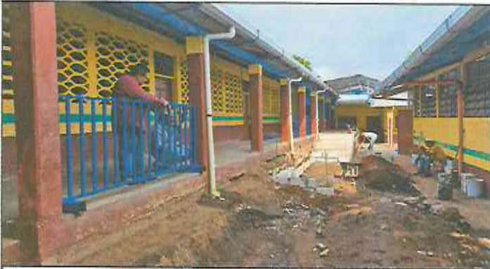
Foto 3: Instalación de baranda metálica en corredor.
