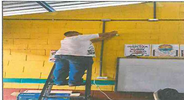
Foto 3: Sustitución de ventiladores.
