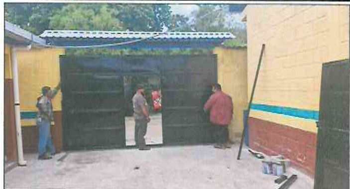
Foto 2: Sustitución de portón de ingreso de 2.5m x 4.00m y techado en área de portón con costanera + lamina troquelada aluzinc cal. 26.
