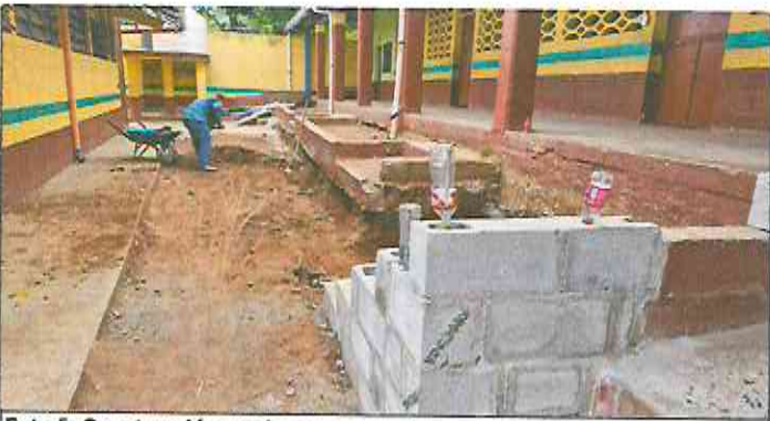
Foto 5: Construcción gradas en escenario.
