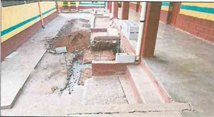
Foto 3: Construcción gradas en escenario.
