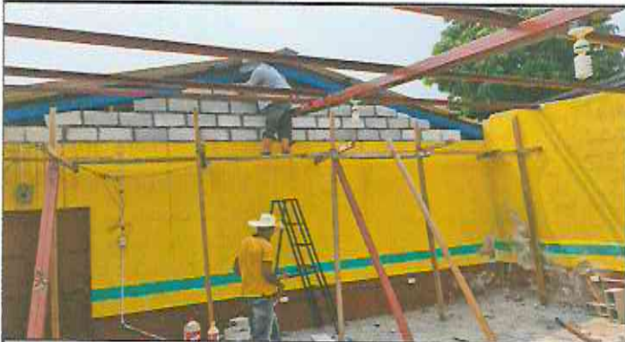
Foto 3: Levantado de hiladas de block.
