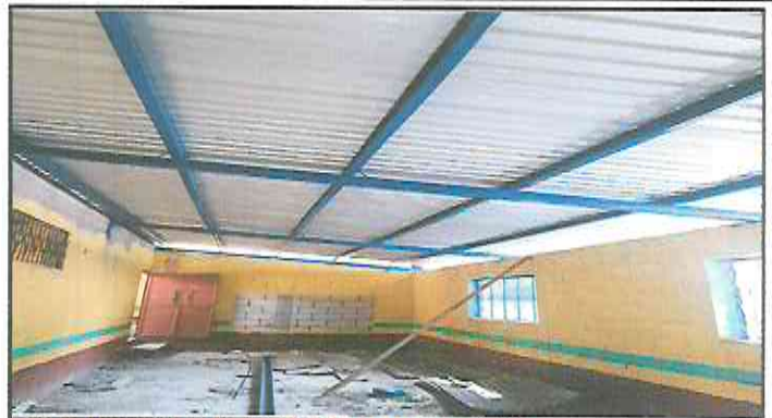
Foto 2: Instalación de lámina troquelada aluzinc cal. 26.
