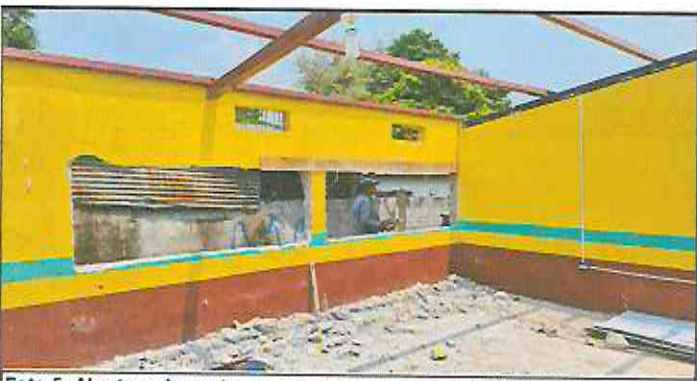
Foto 5: Abertura de ventanas en muro existente de 2.00x1.00mts.
