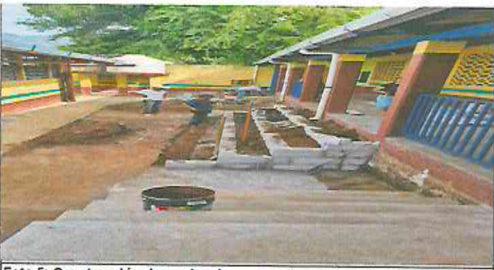
Foto 5: Construcción de gradas de acceso al corredor y banqueta.
