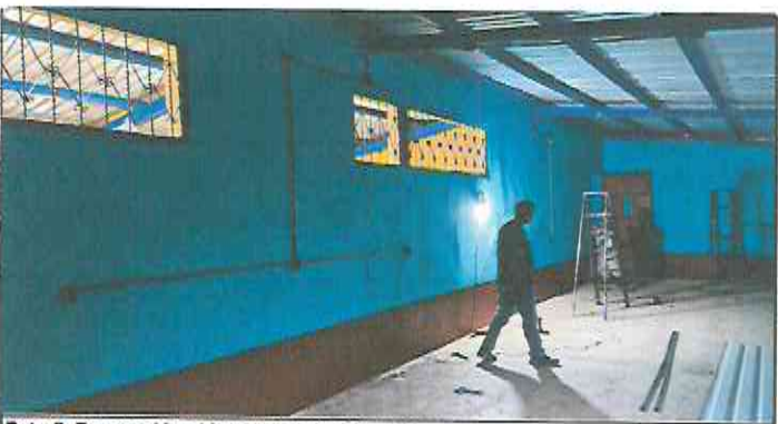
Foto 5: Reparación eléctrica iluminación y fuerza.
