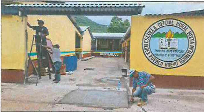
Foto 1: Sustitución de portón de ingreso de 2.5m x 4.00m y techado en área de portón con costanera + lamina troquelada aluzinc cal. 26.
