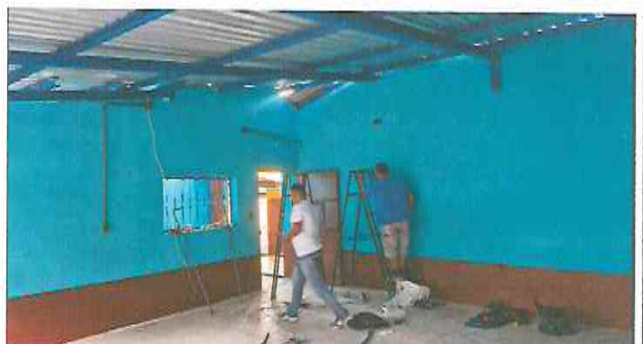
Foto 4: Reparación eléctrica iluminación y fuerza.
