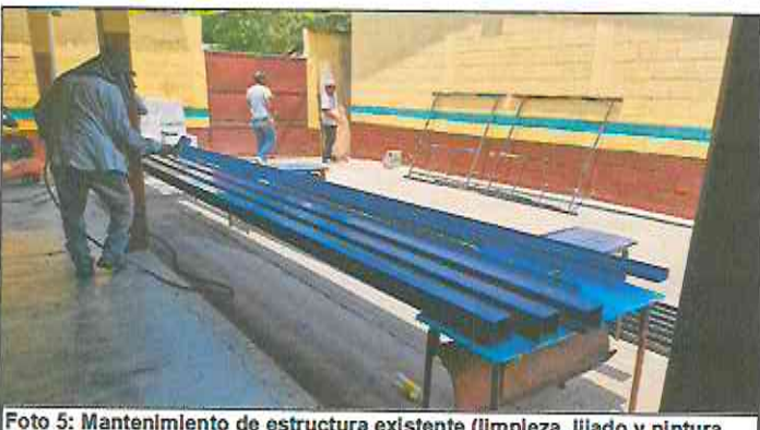
Foto 5: Mantenimiento de estructura existente (limpieza, lijado y pintura anticorrosiva), reforzamiento de estructura con costanera de 2x4.
