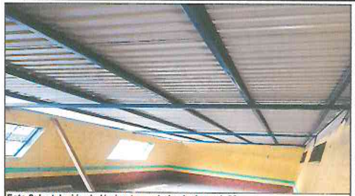
Foto 2: Instalación de lámina troquelada aluzinc cal. 26.
