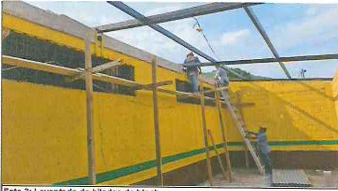
Foto 3: Levantado de hiladas de block.
