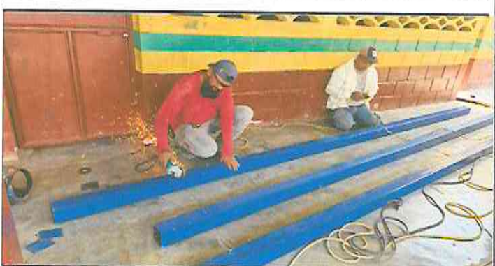
Foto 6: mantenimiento de estructura existente (limpieza, lijado y pintura anticorrosiva), reforzamiento de estructura con costanera de 2x6.
