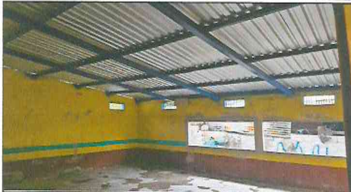
Foto 1: Instalación de lámina troquelada aluzinc cal. 26.
