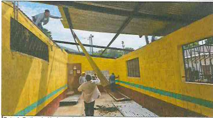
Foto 1: Retiro de lámina existente.
