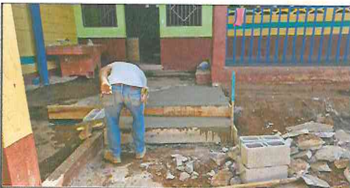
Foto 5: Reparación de torta de cemento e instalación de piso cerámico (antideslizante).
