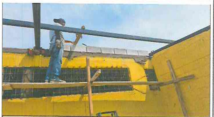
Foto 4: Levantado de hiladas de block.
