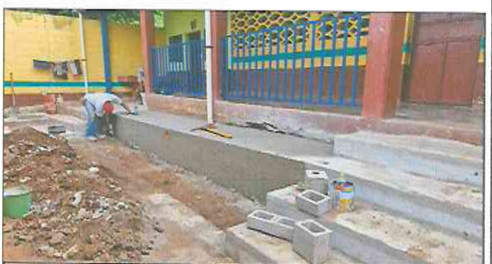
Foto 6: Construcción de gradas de acceso al corredor y banqueta.
