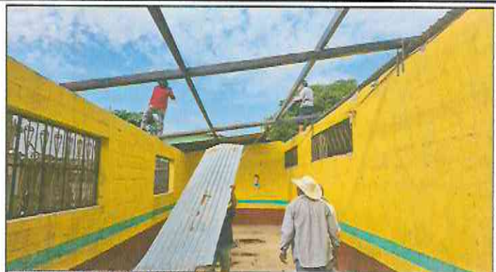
Foto 2: Retiro de lámina existente.
