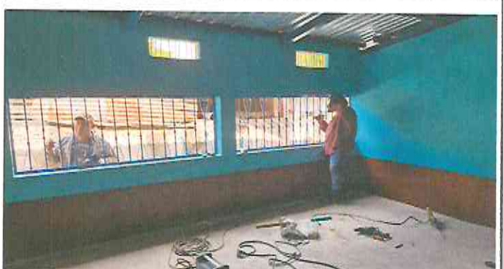
Foto 6: Instalación de balcones en ventanas de 2.00x1.00mts
