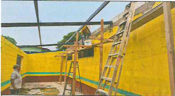
Foto 3: Levantado de hiladas de block.
