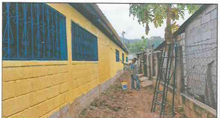
Foto 4: Pintura en balcones existentes y pintura de interior y exterior.
