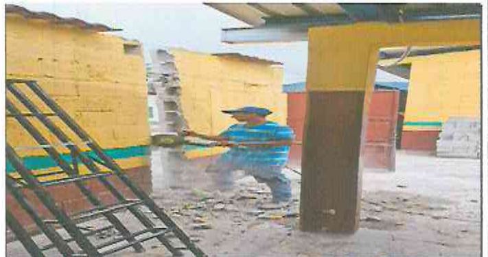
Foto 4: Sustitución de portón de ingreso de 2.5m x 4.00m y techado en área de portón con costanera + lamina troquelada aluzinc cal. 26.
