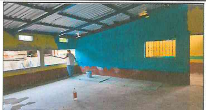
Foto 2: Pintura en balcones existentes y pintura de interior y exterior.
