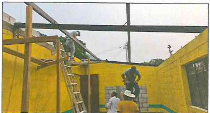
Foto 4: Levantado de hiladas de block.
