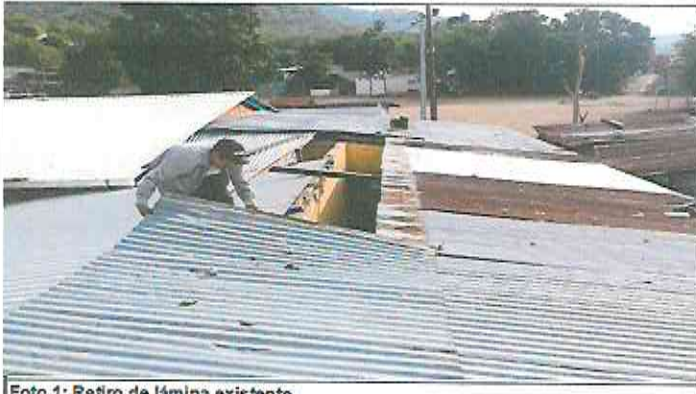
Foto 1: Retiro de lámina existente.
