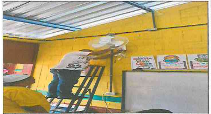
Foto 2: Sustitución de ventiladores.
