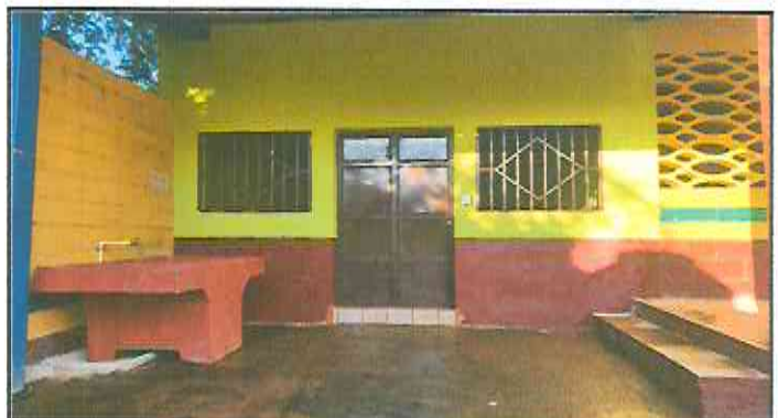
Foto 4: Reparación de torta de cemento e Instalación de piso cerámico (antideslizante).
