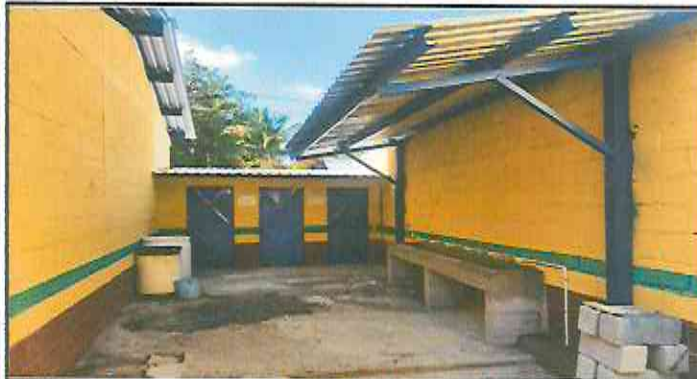
Foto3: Instalación de piso cerámico (antideslizante) y pintura interior, exterior y puertas.
