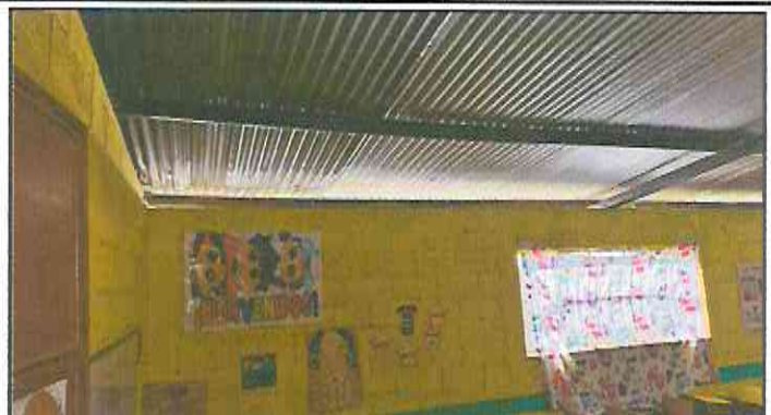
Foto2: Retiro de lámina existente, mantenimiento de estructura existente (limpieza, lijado y pintura anticorrosiva), reforzamiento de estructura con costanera de 2x4, instalación de lámina troquelada aluzinc cal. 26.
