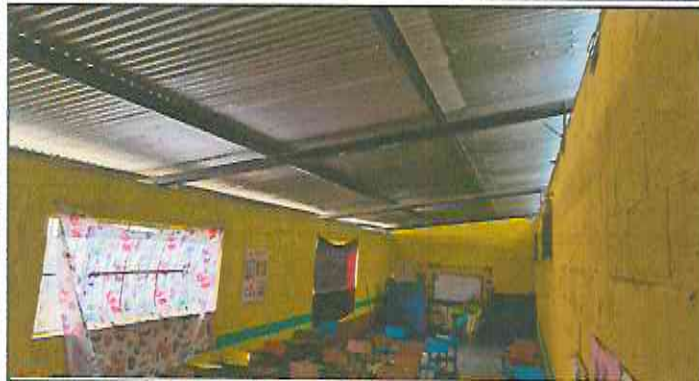
Foto1: Retiro de lámina existente, mantenimiento de estructura existente (limpieza, lijado y pintura anticorrosiva), reforzamiento de estructura con costanera de 2x4, instalación de lámina troquelada aluzinc cal. 26.
