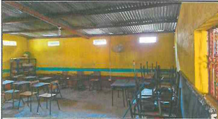
Foto1: Abertura de ventanas en muro existente de 2.00x1.00mts, instalación de balcones en ventanas de 2.00x1.00mts, pintura interior y exterior, pintura interior y exterior.
