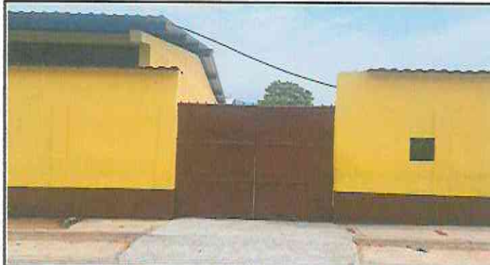
Foto3: Sustitución de portón de ingreso de 2.5m x 4.00m y techado en área de portón con costanera + lamina troquelada aluzinc cal. 26.
