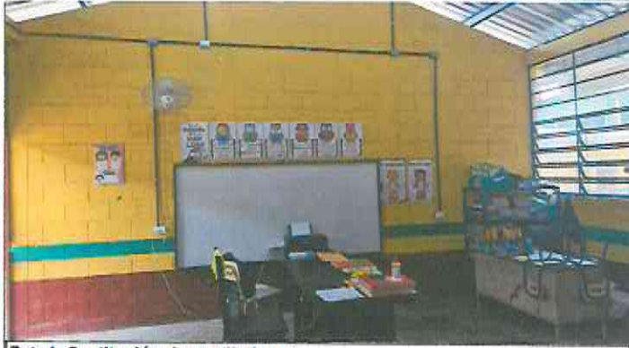
Foto1: Sustitución de ventiladores.
