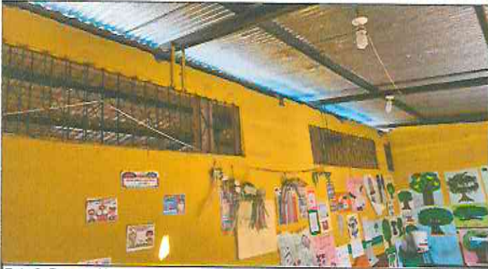
Foto 3: Reparación eléctrica iluminación y fuerza, levantado de hiladas de block.
