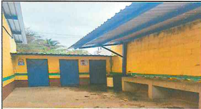
Foto1: Instalación de piso cerámico (antideslizante) y pintura interior, exterior y puertas.
