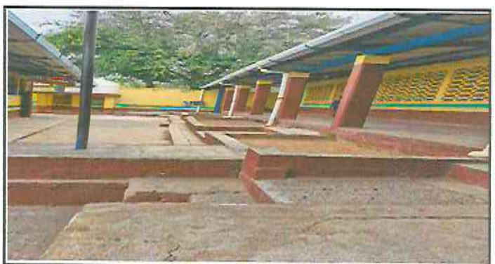
Foto6: Construcción gradas en escenario, instalación de baranda metálica en corredor, pintura en escenario, construcción de gradas de acceso al corredor y banqueta.
