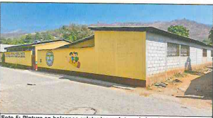
Foto 5: Pintura en balcones existentes y pintura de interior y exterior.
