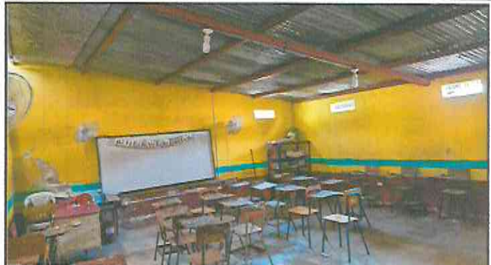
Foto2: Abertura de ventanas en muro existente de 2.00x1.00mts, instalación de balcones en ventanas de 2.00x1.00mts, pintura interior y exterior, pintura interior y exterior.
