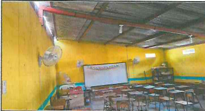
Foto3: Retiro de lámina existente, mantenimiento de estructura existente (limpieza, lijado y pintura anticorrosiva), reforzamiento de estructura con costanera de 2x6, instalación de lámina troquelada aluzinc cal. 26.
