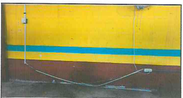
Foto6: Reparación eléctrica iluminación y fuerza,
