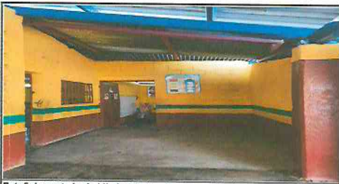
Foto5: Levantado de hileras de block, pintura interior y exterior.
