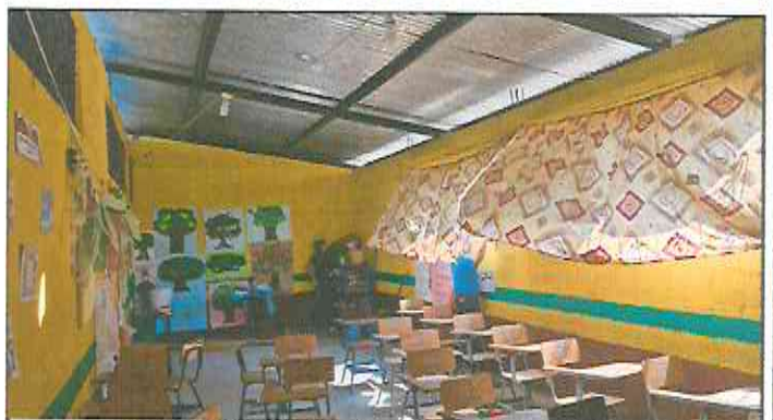
Foto 4: Reparación eléctrica iluminación y fuerza, levantado de hiladas de block.
