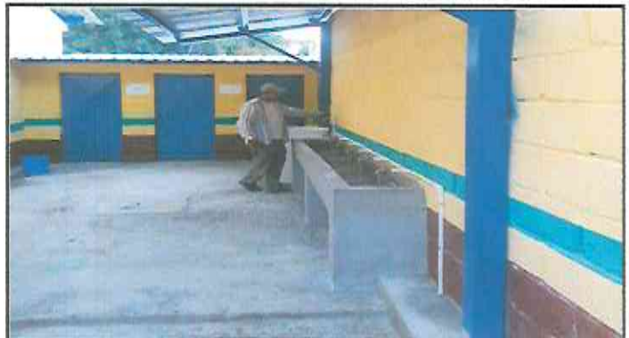
Foto2: Instalación de piso cerámico (antideslizante) y pintura interior, exterior y puertas.
