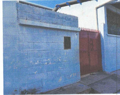
FOTO 8: SUSTITUCIÓN DE PORTÓN CORREDIZO CON PUERTA INCORPORADA MIDE ALTO 2.4 MTS. U LARGO 4.10 MTS
