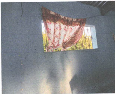
Foto 3: INSTALACIÓN DE BALCONES DE METAL ✓
