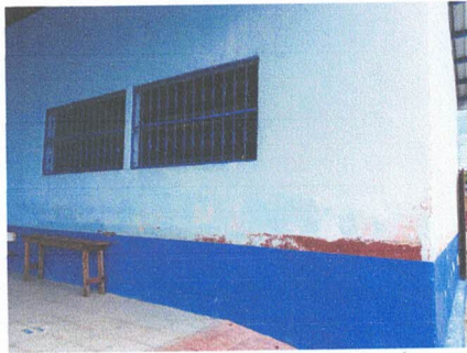
FOTO 10: PINTURA DE MUROS EXTERIORES E INTERIORES ✓
