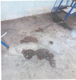
Foto1: SUSTITUCIÓN DE PISO DE TORTA LISA POR PISO CERAMICO MATE ✓
