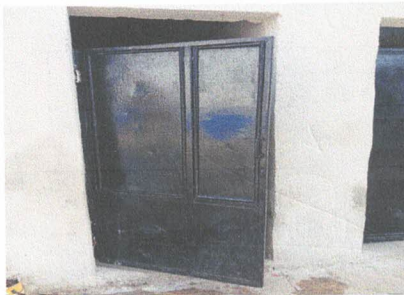
Foto 5: MANTENIMIENTO DE PUERTA (LIJADO Y PINTURA) ✓
