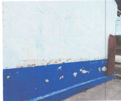
FOTO 11: PINTURA DE MUROS EXTERIORES E INTERIORES ✓
