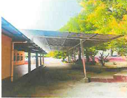
Foto 1: Cambio de techo y estructura de patio de la escuela.
