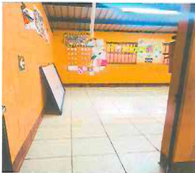
Foto 5: Cambio de piso en aula 1
