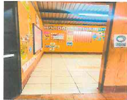
Foto 6: Cambio de piso en aula 2.
