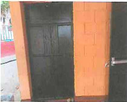
Foto 3: reparacion de puerta de cocina.
