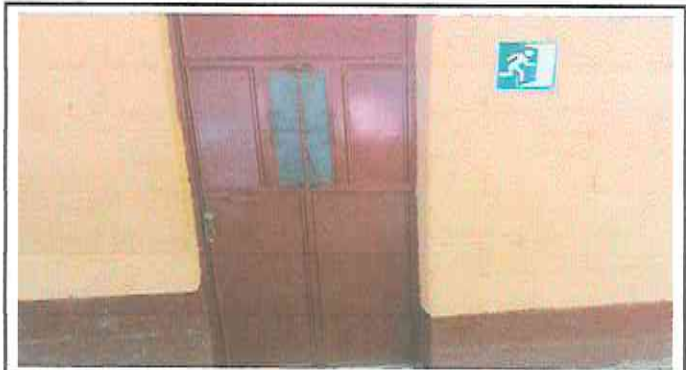
Foto 3: reparacion de puerta de cocina.
