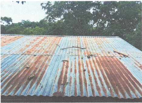
Foto 9: sustitución de techo cocina ✓
