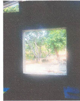
Foto 4: fabricación e instalación balcon metalico, aula 1
