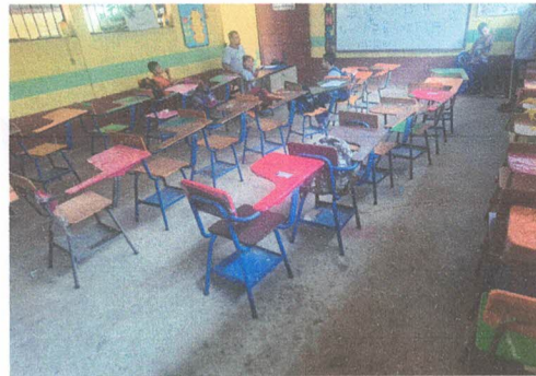
Foto 12: colocación de piso cerámico aula 3 ✓
