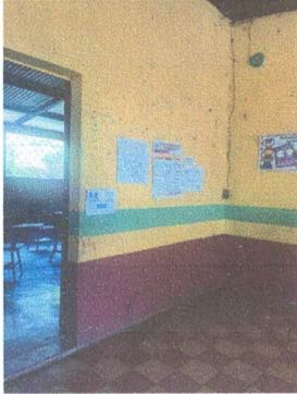
Foto 7: cortado, tallado y colocación de puerta aula 2 ✓
