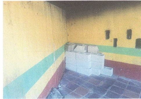
Foto 8: Fundición de mesa, gabinetes, colocación de cerámico en gabinetes de cocina ✓
