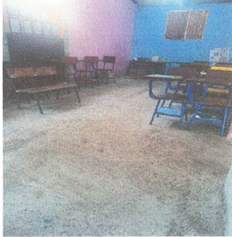
Foto 1: Sustrucción de piso aula 1
