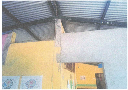
Foto 2: levantado hiladas de block en muro de aula 1
