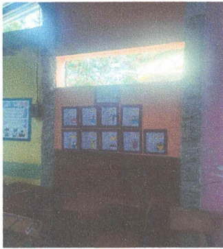
Foto 3: Repello de muro aula 1
