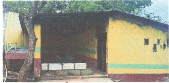
Foto 10: levantado de hiladas de block y repello de muro, cocina ✓
