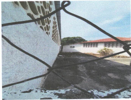
Foto 3: SUSTITUCIÓN DE TUBERÍA PVC 100 PSI DE 4 PULGADAS CON SU RESPECTIVA CAJA
