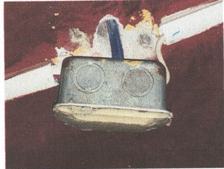
FOTO 14: REPARACIÓN DE SISTEMA DE ILUMINACIÓN Y FUERZA ( CABLE, TOMACORRIENTES, APAGADORES, FILIPONES ENTRE OTROS)
