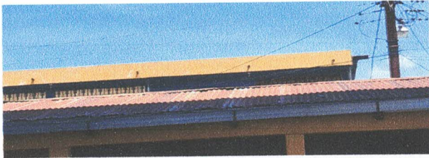
Foto1: SUSTITUCIÓN DE LAMINA POR LAMINA TROQUELADA ALUZING CALIBRE 26
