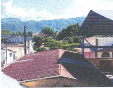
FOTO 19: SUSTITUCIÓN DE LAMINA POR LAMINA TROQUELADA ALUZINC CALIBRE 26
