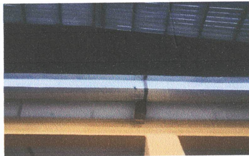
Foto 5: SUSTITUCIÓN DE CANAL DE METAL
