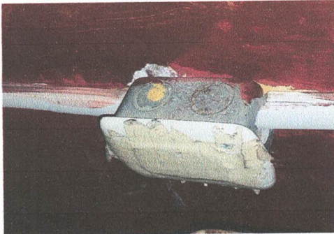
FOTO 15: REPARACIÓN DE SISTEMA DE ILUMINACIÓN Y FUERZA ( CABLE, TOMACORRIENTES, APAGADORES, FILIPONES ENTRE OTROS)
