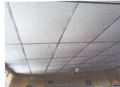
Foto 6: DESISTALACIÓN DE CIELO FALSO
