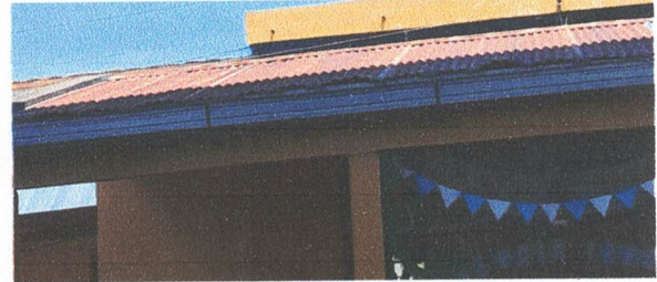
Foto 2: RETIRO DE LAMINA EXISTENTE
