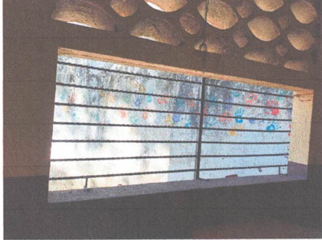
FOTO 7: COLACIÓN DE VENTANA PVC AULA 1 1.48 M2
