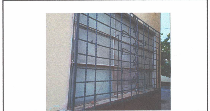
FOTO 14: PINTURA DE BALCONES
