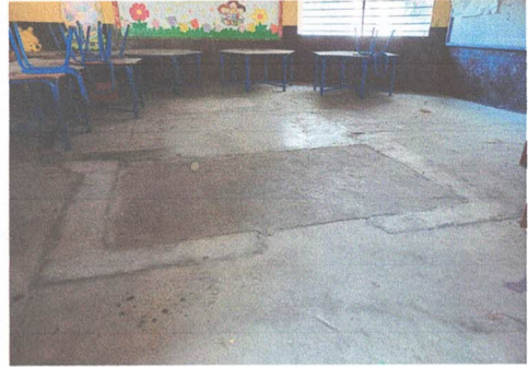
FOTO 10: SUSTITUCIÓN DE PISO CONCRETO POR PISO LISO EN AULA
