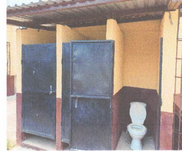
FOTO 4: MANTENIIENTO DE PUERTAS EXISTENTES
