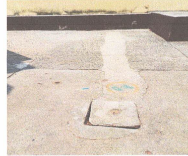
FOTO 2: SUSUTITUCION DE CONCRETO EN TUBERIA DE AGUAS NEGRAS
