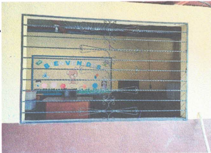
FOTO 5: COLOCACIÓN DE VENTANA PVC
