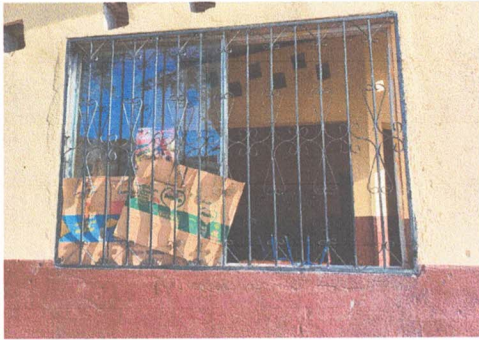
FOTO 9: SUSTITUCIÓN DE VENTANA AULA 3 3.00 M2
