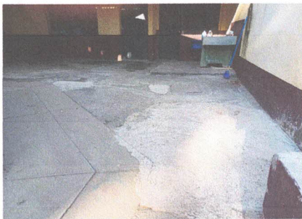
FOTO 11: SUSTITUCION DE PISO DE CONCRETO DE PASILLO
