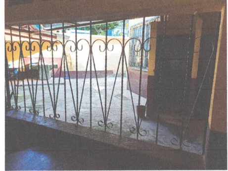
FOTO 8: COLOCACIÓN DE VENTANA AULA 1 1.89 M2
