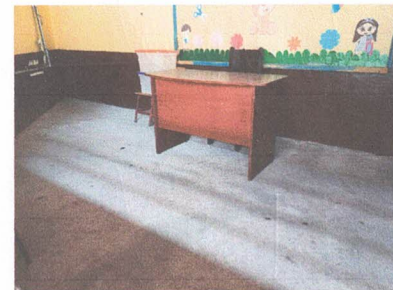
FOTO 6: COLOCACIÓN DE PISO CERÁMICO
