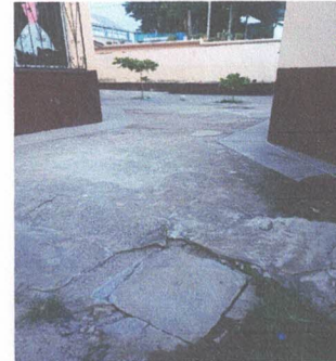
FOTO 12: SUSTITUCIÓN DE PISO EN PATIO
