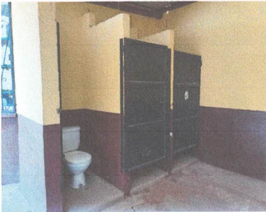
FOTO 3: REEMPLAZO DE ACCESORIOS DE SANITARIOS
