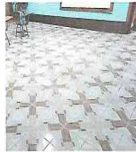
FOTO 8: COLOCACIÓN DE PISO CERÁMICO
