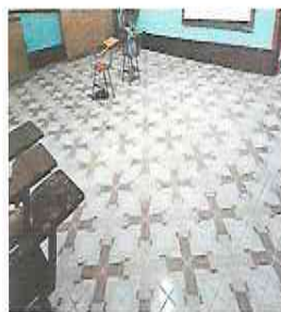
FOTO 2: INSTALACION PISO CERAMICO EN MODULO 2
