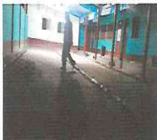
FOTO 5: FUNDICION PISO CONCRETO EN MODULO 2
