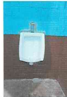
FOTO 10: SUSTITUCION E INSTALACION DE MINGITORIO
