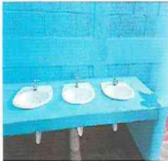
FOTO 9: SUSTITUCION DE ACCESORIOS EN LAVAMANOS
