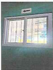
FOTO 3: COLOCACIÓN DE VENTANA PVC
