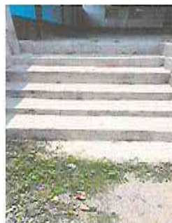
FOTO 6: REPARACIÓN DE GRADAS DE INGRESO
