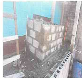
FOTO 4: REPARACIÓN DE AREA DE PILA (MURO DE CONCRETO)
