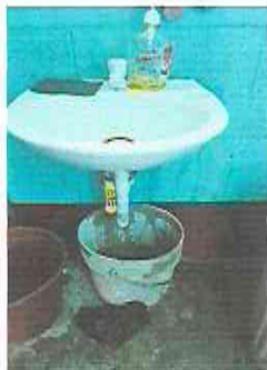
FOTO 9: SUSTITUCION DE ACCESORIOS EN LAVAMANOS
