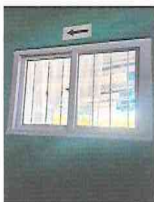
FOTO 3: COLOCACIÓN DE VENTANA PVC
