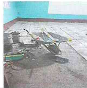
FOTO 2: INSTALACION PISO CERAMICO EN MODULO 2
