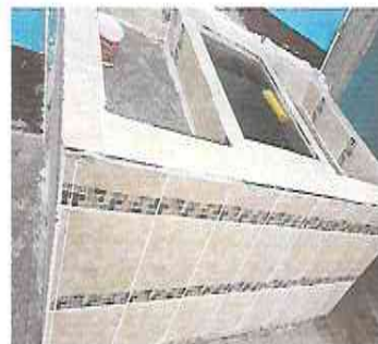
FOTO 4: REPARACIÓN DE AREA DE PILA (MURO DE CONCRETO)
