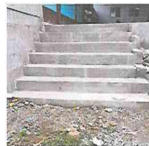
FOTO 6: REPARACIÓN DE GRADAS DE INGRESO
