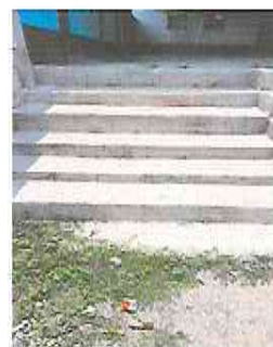
FOTO 6: REPARACIÓN DE GRADAS DE INGRESO
