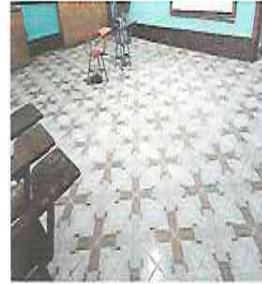
FOTO 2: INSTALACION PISO CERAMICO EN MODULO 2
