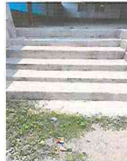
FOTO 6: REPARACIÓN DE GRADAS DE INGRESO
