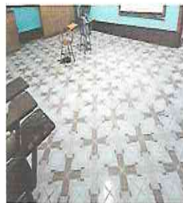
FOTO 2: INSTALACION PISO CERAMICO EN MODULO 2
