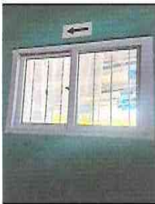
FOTO 3: COLOCACIÓN DE VENTANA PVC
