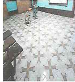
FOTO 2: INSTALACION PISO CERAMICO EN MODULO 2
