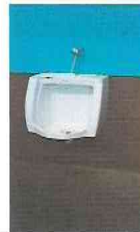
FOTO 10: SUSTITUCION E INSTALACION DE MINGITORIO
