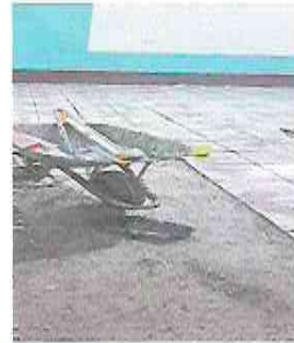
FOTO 8: COLOCACIÓN DE PISO CERÁMICO
