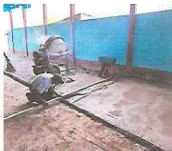
FOTO 5: FUNDICION PISO CONCRETO EN MODULO 2
