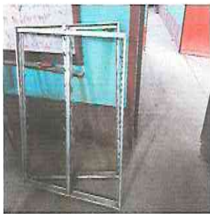
FOTO 3: COLOCACIÓN DE VENTANA PVC
