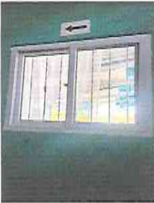
FOTO 3: COLOCACIÓN DE VENTANA PVC
