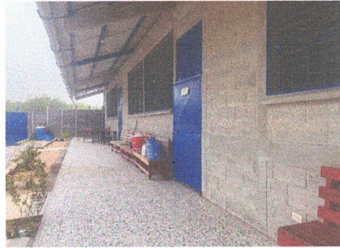
Foto 2: Pintura de balcones y puertas de aulas
