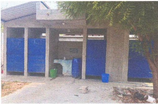
Foto 3: Pintura de puertas de baños
