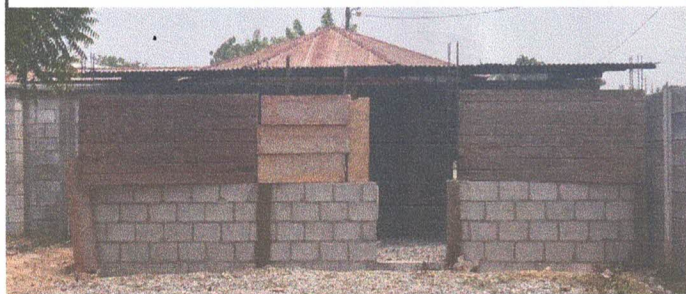
Foto 5: Sustitución cerramiento de madera por block en módulo de dirección.
