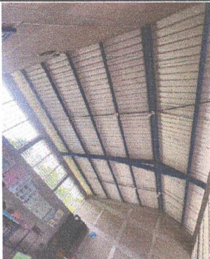
Foto 9: Fabricación e instalación de cielo falso en modulo de aula 2
