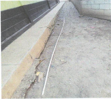
Foto 1: SUSTITUCIÓN DE BANQUETA DE CONCRETO ✓
