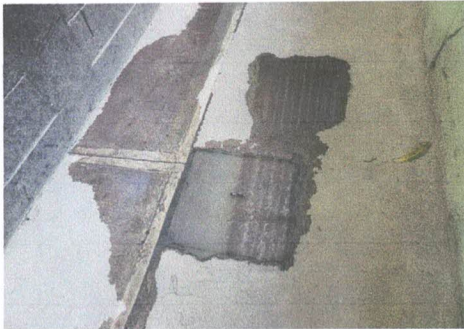
Foto 3: SUSTITUCIÓN DE CONDUCCIÓN DE TUBERIA DE AGUAS HÉRVIDAS ✓
