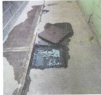
Foto 2: SUSTITUCIÓN DE CONDUCCIÓN DE TUBERIA DE AGUAS HÉRVIDAS ✓
