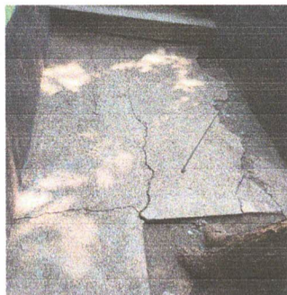
Foto 1: sustitución de plancha de concreto.
