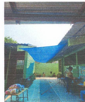
Foto 6: sustitucion de puertas de metal.
