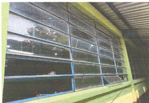
Foto 3: colocación de balcanones de metal.
