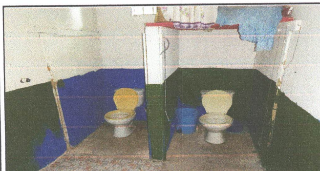
SUMINISTRO E INSTALACION DE PUERTAS DE PVC EN AREA DE BAÑOS UBICADO EN AREA INTERIOR DE AULAS
