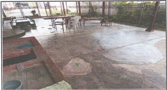
SUMINISTRO E INSTALACION DE PISO CERAMICO EN CORREDOR
