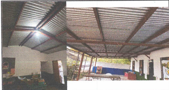
SUMINISTRO E INSTALACION DE SISTEMA ELECTRICO EN AREA DE AULAS Y GALERIA EXTERIOR INCLUYE (CABLE, PLAFONERAS, CAJAS OCTOGONALES, ABRAZADERAS, INTERRUPTORES, FOCO LED DE BUENA ILUMINACION) EL ESTABLECIMIENTO ES JORNADA VESPERTINA Y COMO EN LAS AULAS ES MUY ENCERRADO EL ESPACIO ES POCA ILUMINACION LA QUE ENTRA Y POR ESO ES NECESARIA UNA BUENA ILUMINACION
