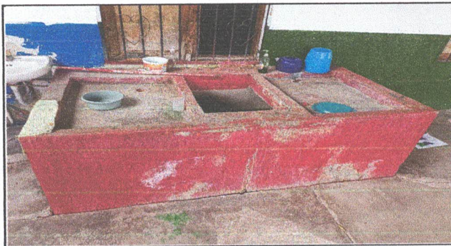
SUMINISTRO E INSTALACION DE PISO CERAMICO EN PILA
