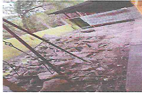
Foto 2: Demolición de muro y concreto de la Escuela
