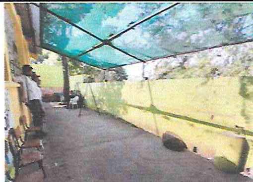
Foto 4: área donde se instalará techo de lamina y estructura metálica.
