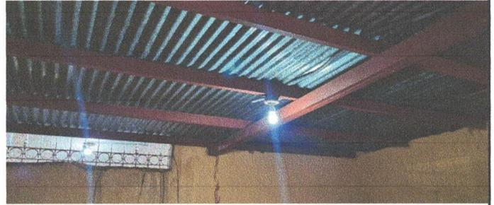
Foto 2: Sustitucion de lamina por lamina troquelada aluzinc calibre 26
