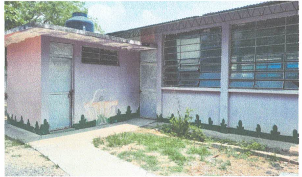
6.1 Pintura a muros interiores y exteriores ✓
