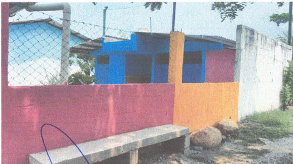
9.1 Baranda sobre muro perimetral ✓
