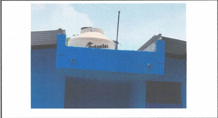
11.1 Sustitución de accesorios de depósito de agua ✓
