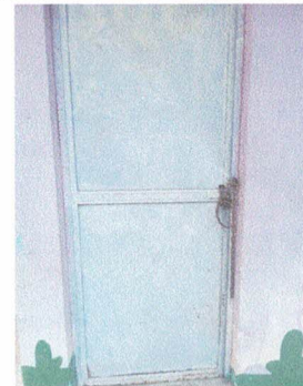
3.2 Sustitución de puerta a servicio sanitario
