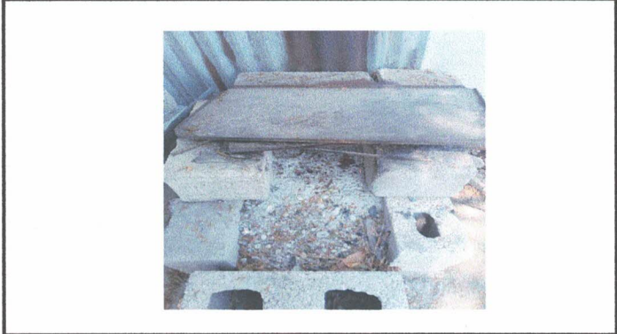
12.1 y 12.2 Sustitución de estufa rural y mueble de concreto y azulejo para alimentos ✓
