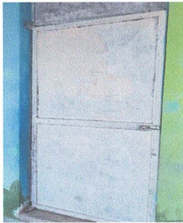
3.1 Mantenimiento a puertas de metal
