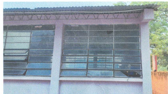
4.1 Sustitución de vidrios
