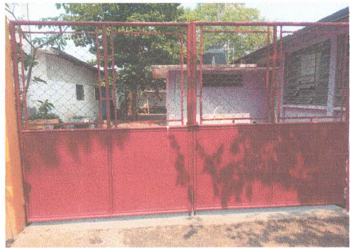
8.1 Mantenimiento a portón de metal ✓
