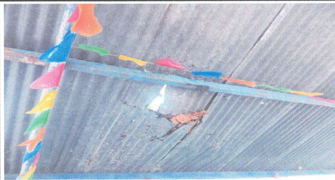
1.1 Sustitución de lamina por lamina troquelada aluzinc
