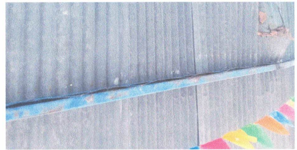
2.1 Sustitución de estructura soporte metal por metal
