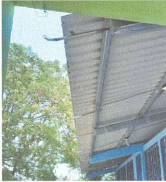
5.1 y 5.2 Sustitución de Canal y Bajada de Agua pluvial ✓
