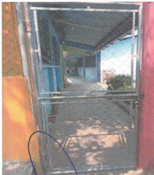
3.3 Sustitución de puerta de ingreso
