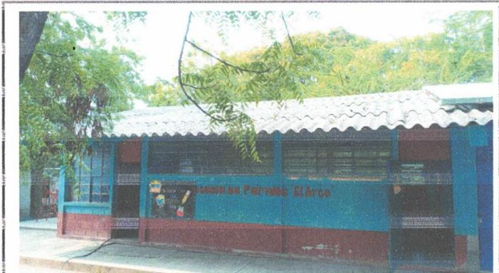
**Foto 5: Sustitucion de lamina por lamina troquelada aluzinc calibre 20**
