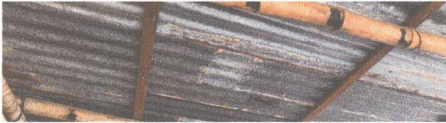
8.2 Sustitución de lamina por lamina troquela aluzic calibre 26 ✓
