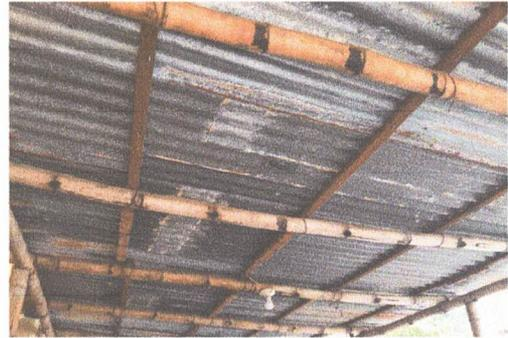
8.1 Sustitución de estructura de madera por metal ✓
