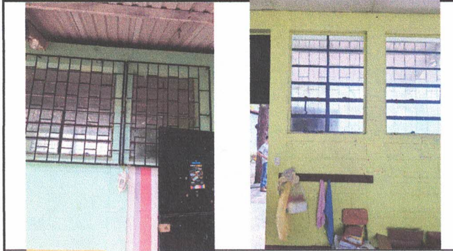
2.4 SUSTITUCION DE VENTANALES DE METAL POR VENTANAS PVC
