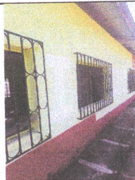
Foto 4: 2.1 SUSTITUCION DE VENTANAS DE METAL POR VENTANAS PVC
