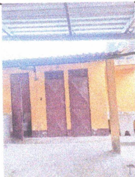
Foto 3: 1.3 PINTURA EN MUROS INTERIORES
