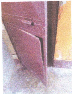
Foto 1: 1.1 MANTENIMIENTO DE PUERTAS DE METAL
