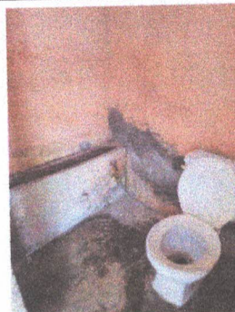
Foto 2: 1.2 SUSTITUCION DE INODOROS
