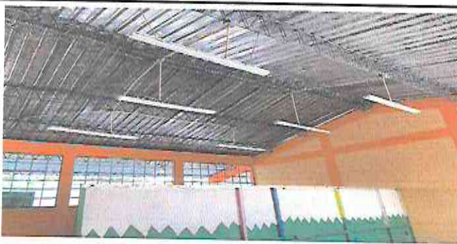
Foto 5: Lamparas Led Nuevas y Pintura en muros Interiores
