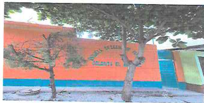
Foto 4: Puerta de Ingreso nueva y Pintura en muros Exteriores
