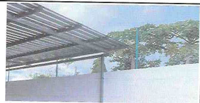
Foto 6: Reparación de Tubo y Malla Nueva
