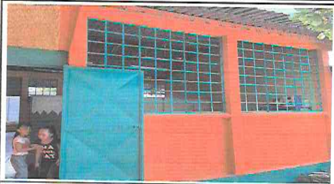
Foto 2: Cambio de ventana Balcon a Balcon
