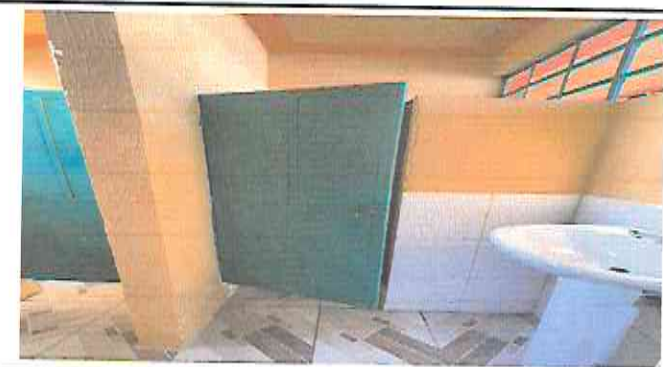
Foto 10: Puertas en Sanitarios
