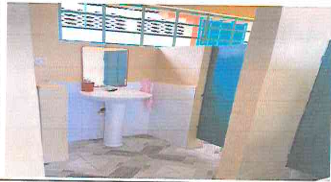
Foto 8: Lavamanos, Azulejo y Puertas en los sanitarios
