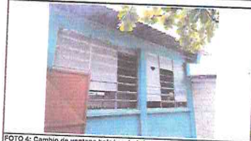
FOTO 4: Cambio de ventana balcón a balcón
