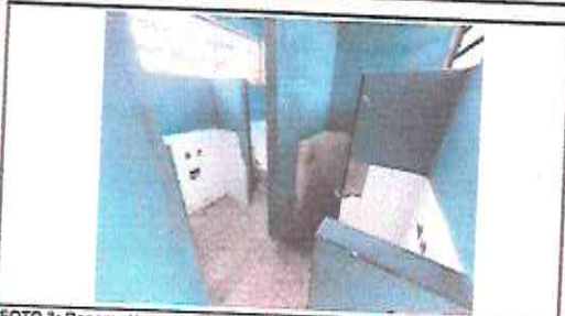
FOTO 3: Reparación o sustitución de azulejos, Sustrucción de puertas en Servicios sanitarios.
