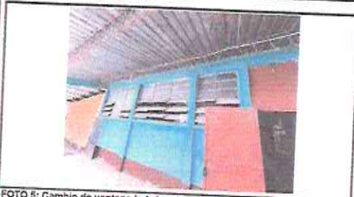
FOTO 5: Cambio de ventana balcón a balcón,
